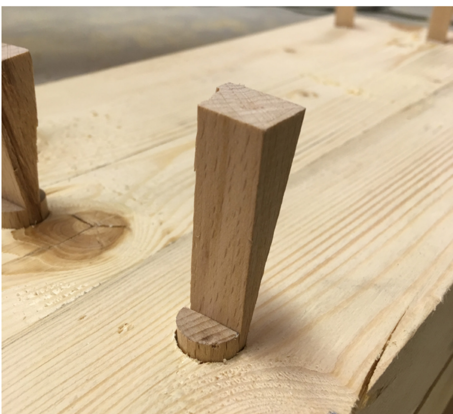
Leimfreie Holzverbindungen über Buchendübel
