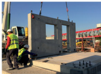
PANNELLO PORTANTE PREFABBRICATO RE 4 CON CDW
